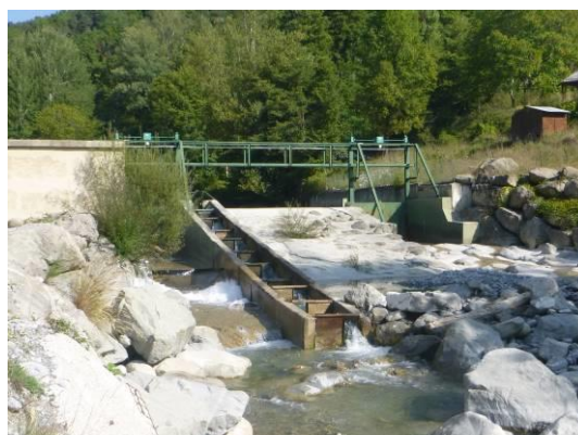
Microcentrale - Pont de Gassinié / Pont de la Donne
