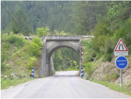
RD 110 et voie ferrée, au Sud
